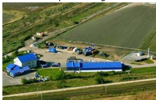
Fig. 31: Depozit deșeuri municipale A.S.A. Arad Sursa: http://www.asa-group.com/
